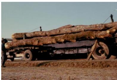
Au début, le chargement se faisait avec des treuils. On enlevait les ranchets (poteaux verticaux fixés de chaque côté de la plateforme du camion), on mettait des traverses, puis on faisait monter l'arbre sur la remorque avec le treuil, qui fonctionnait avec le
