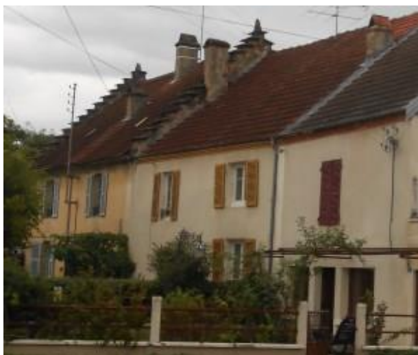
Desnes : toitures avec pignons à redents
